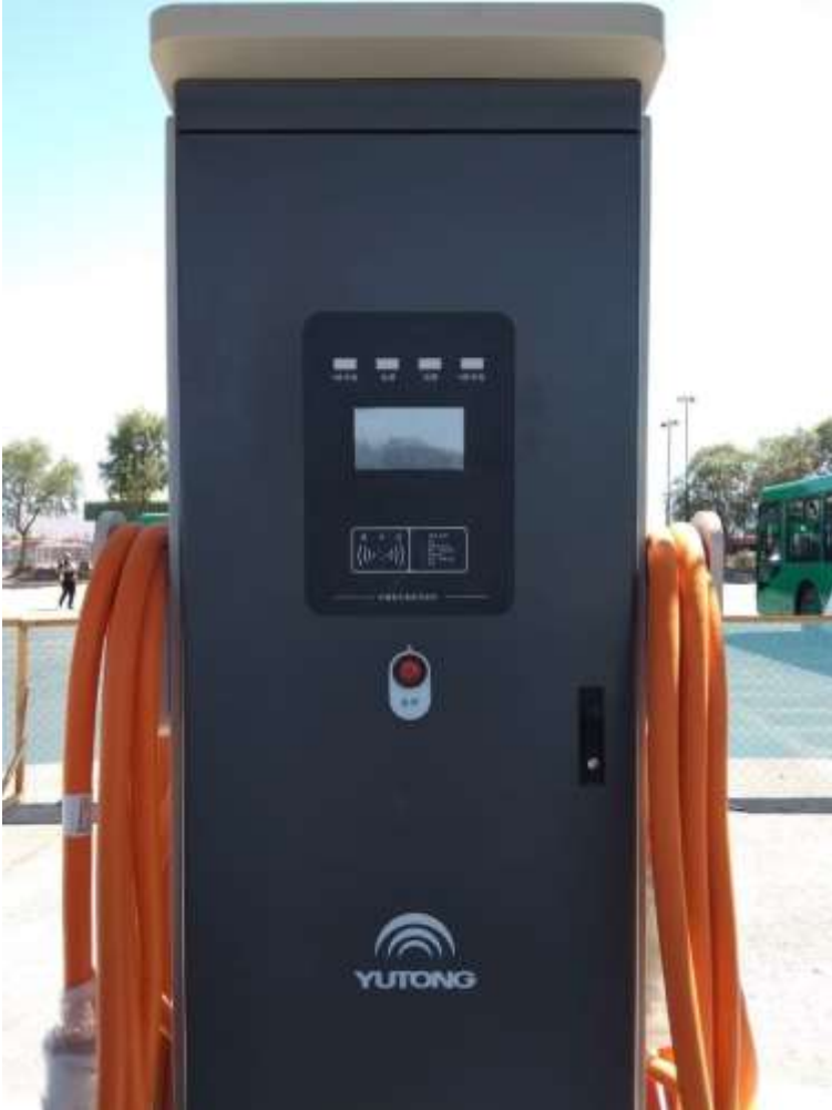
Cargador eléctrico salida DC 150kW (Grasen)
